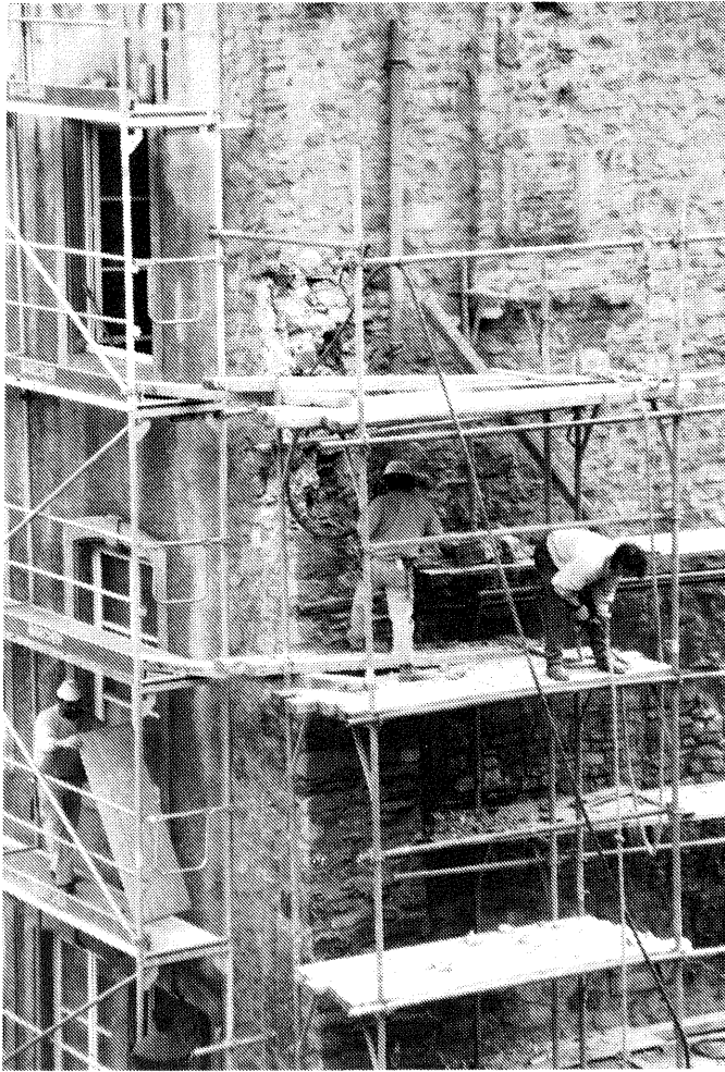
Mit dem Preßlufthammer wurden die Elemente der früheren Hausstruktur an der Westfassade des Ilot du Rost wegradiert - mit dem Einverständnis des Denkmalschutzamtes (!?).
