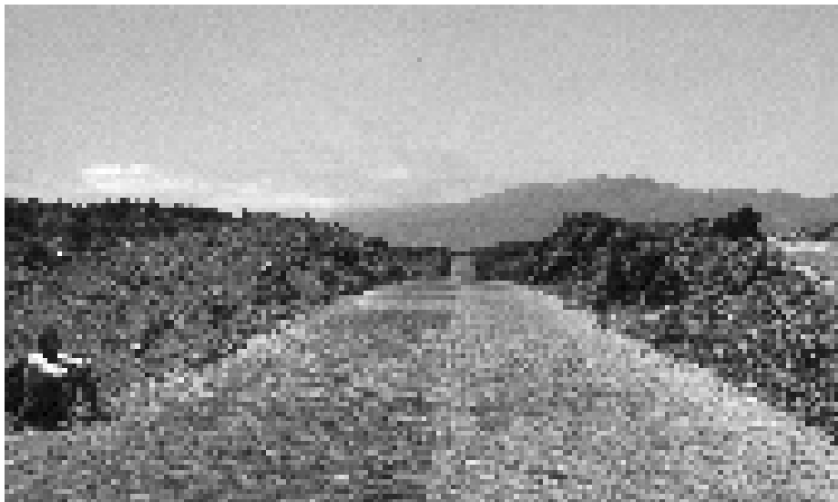
Construction d'une route. Photo: Ministère de la coopération
