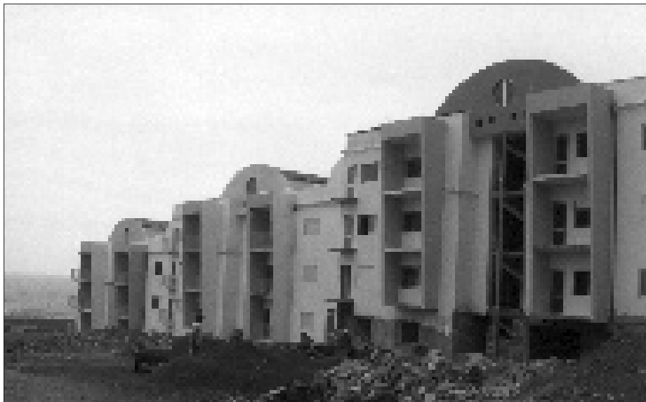
Habitat social à Ponta do Sol (Santo Antão) Photo: Ministère de la coopération
