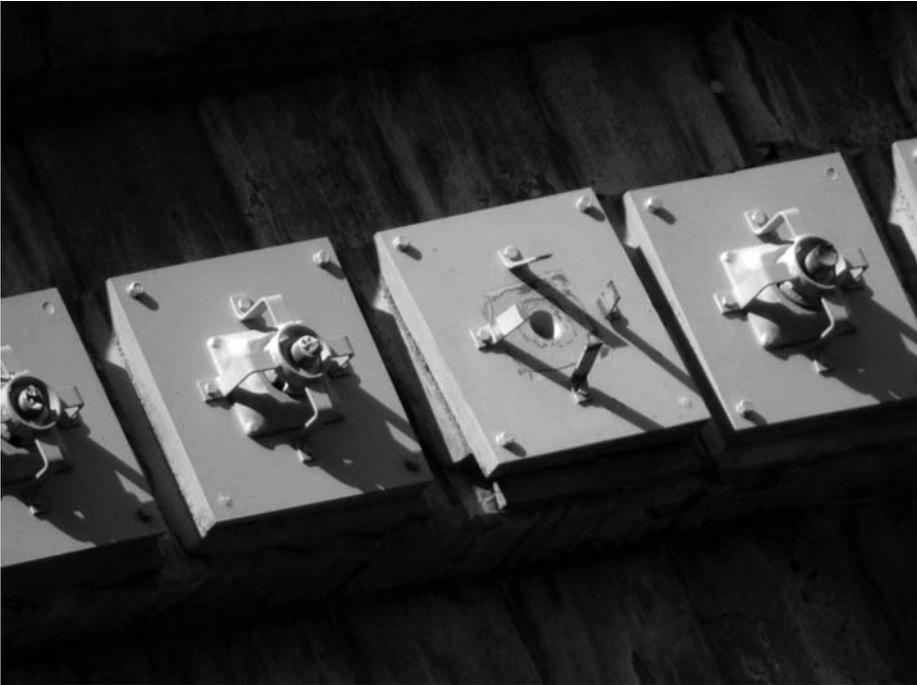
Defekter Zuganker am Pont Adolphe (Foto: Administration des ponts et chaussées)
