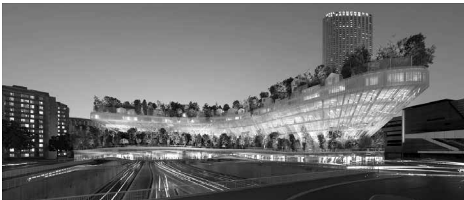
« Mille arbres » : un immeuble pont au-dessus du périphérique, sorte de pyramide inversée qui libère un maximum d'espace accessible au public tout en ayant une emprise au sol limitée. Il comporte aussi un village sur le toit et un jardin potager.
