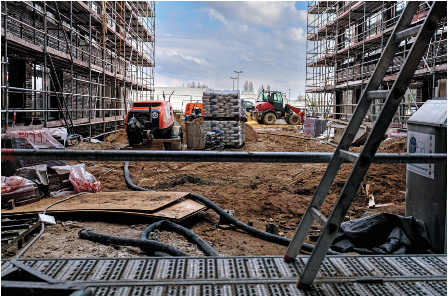
Vorzeigebaustelle im Rahmen der ITM-Presskonferenz
